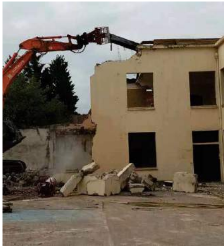
Déconstruction du 12 avenue de Paris sur le Campus Pierre Mendès-France
