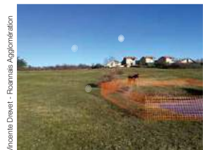
Protection d'une mare en amont du chantier de la plage de Villerest
