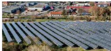
Parc solaire de Montretout - Vue du drone
