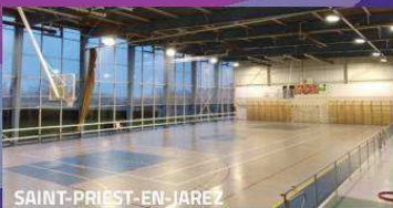
SAINT-PIEST-EN-JAREZ RÉNOVATION D'ÉCLAIRAGE INTÉRIEUR
