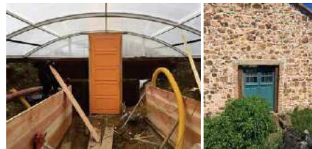
Réemploi d'une ancienne porte du 12 avenue de Paris dans une ferme du Roannais
