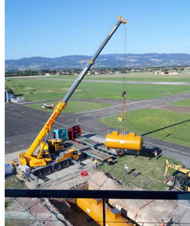
Travaux d'aménagement de la nouvelle station
