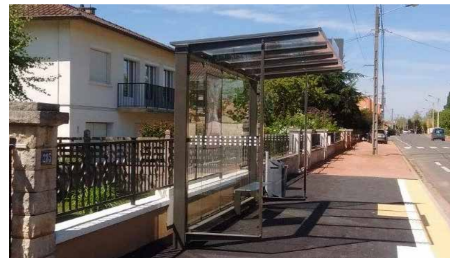
Abri voyageur sur le réseau STAR sur quel bus mis en accessibilité
